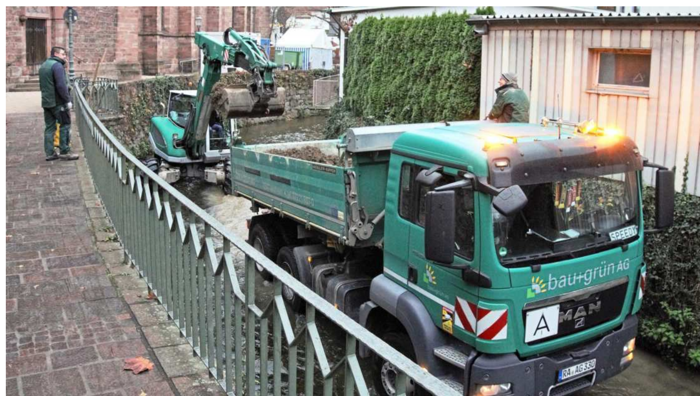
Spektakulärer Anblick: Ein Bagger und ein Lastwagen in der Bühlot bei der Stadtpfarrkirche. Aktuell wird ein sogenannter Fangedamm angelegt, damit die Arbeiter bei der Sanierung der Bachmauer keine nassen Füße bekommen. Foto: Ulrich Coenen
